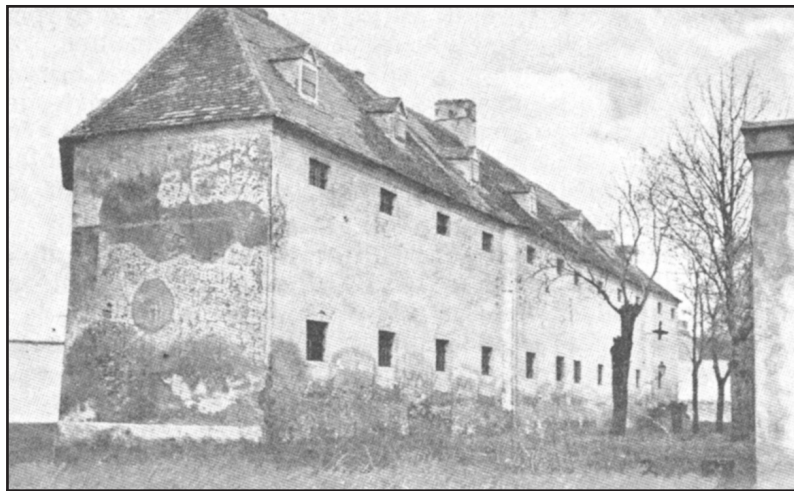
Budova C v Möllersdorfu
